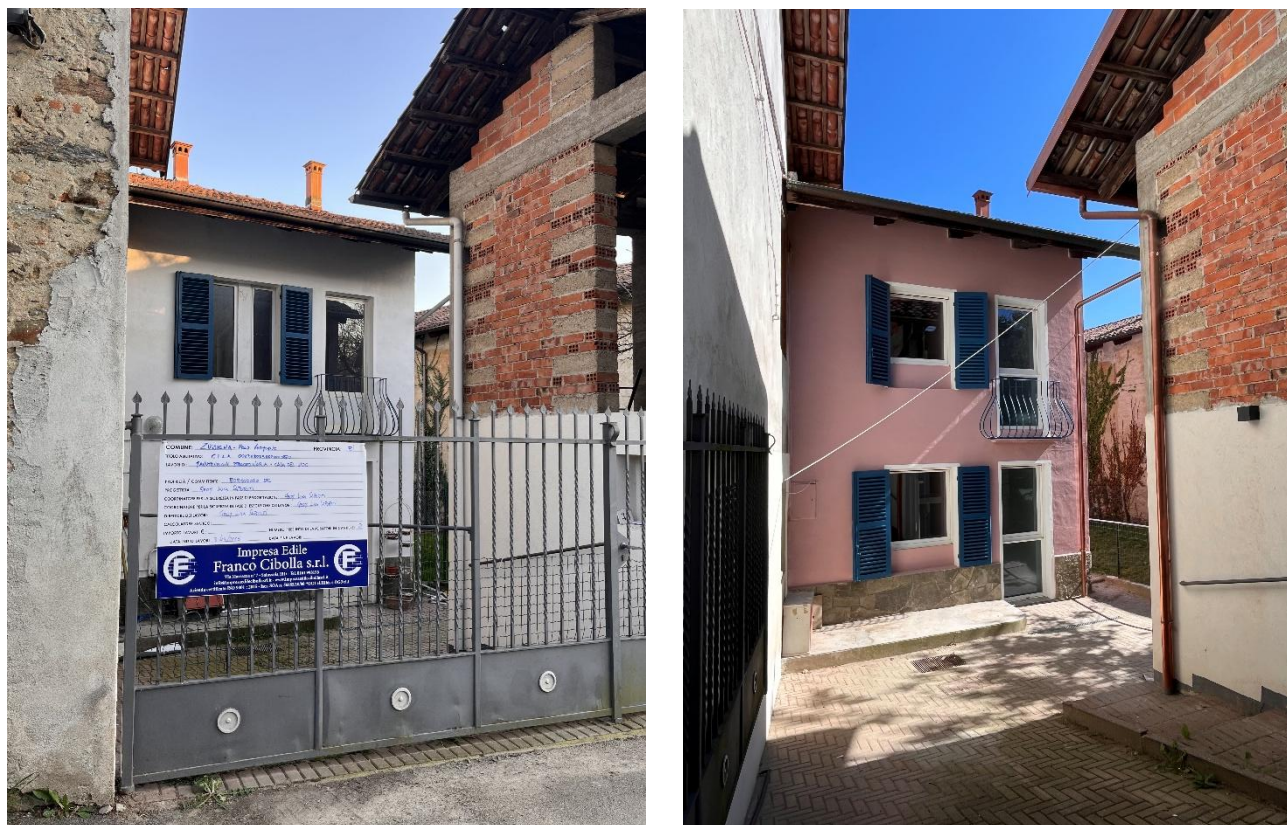
Fig. 4 la Cà del Lido, prima e dopo l'intervento
